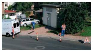
Beim Betreiben von Kabelmesswagen ist im Wesentlichen mit elektrischen Gefährdungen zu rechnen. Da die Messungen überwiegend im öffentlichen Straßenverkehrsraum durchgeführt werden, ergibt sich aber ein zweiter bedeutender Gefährdungsbereich.
