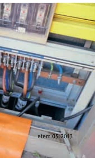
Bisheriger Anschluss: Bei den bisherigen Arbeitsverfahren besteht grundsätzlich eine erhöhte elektrische Gefährdung durch direkt benachbarte spannungsführende Anschlüsse.
