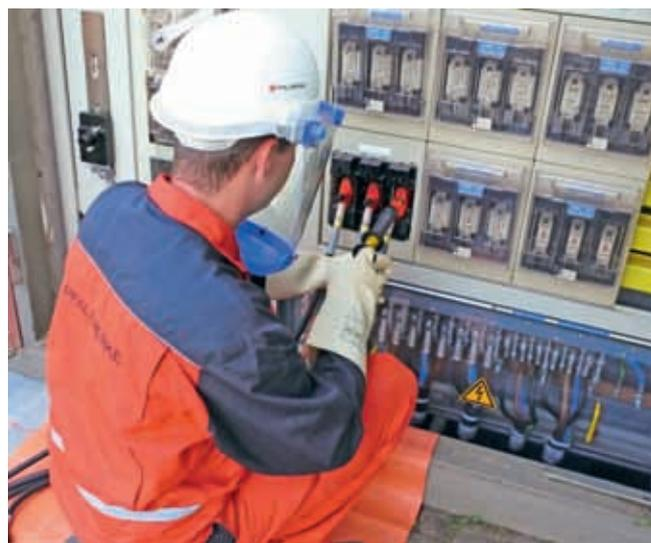
Montagebeispiel: Der isolierte Handgriff gewährleistet einen ausreichenden Abstand und ermöglicht das sichere Einsetzen der einzelnen Steckmesser.
