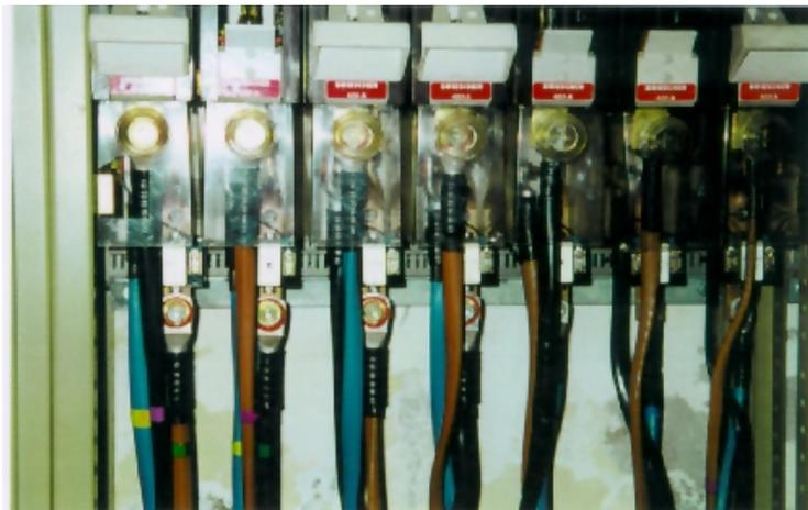
**Bild:** NH-Verteilungen führen bei enger Anordnung immer wieder zu Stromunfällen beim Arbeiten in der Nähe unter Spannung stehender Teile.
