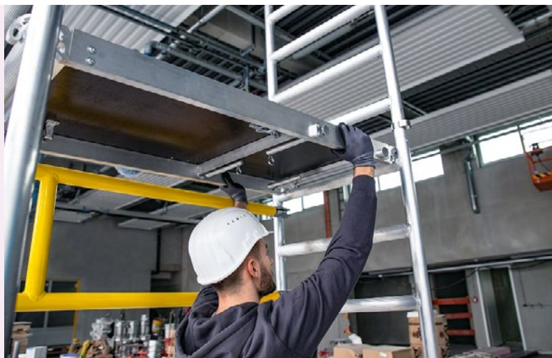
Fahrbare Arbeitsbühnen bieten einen sicheren Stand, müssen aber unbedingt gemäß Gebrauchsanleitung des Herstellers errichtet werden.
