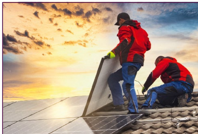
Mit Köpfchen aufs Dach: Zur Installation von Photovoltaikanlagen gehören gute Vorbereitung und Planung.
