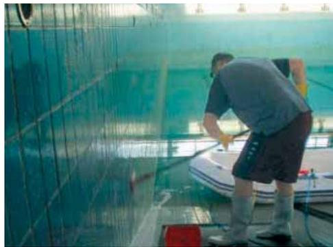
gungsmittel unter Anwendung einer Schaumkanone benetzt, mechanisch bearbeitet und anschließend mit Wasser abgespritzt.
