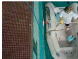
Gesichert wurde das Boot mit zwei Leinen, die von einem Mitarbeiter gehalten wurden. Während das Wasser abgelassen wurde, zog ein Mitarbeiter vom Beckenumgang aus das Boot langsam an den Beckenwänden entlang. Die Reinigung konnte so problemlos und effektiv erledigt werden.
